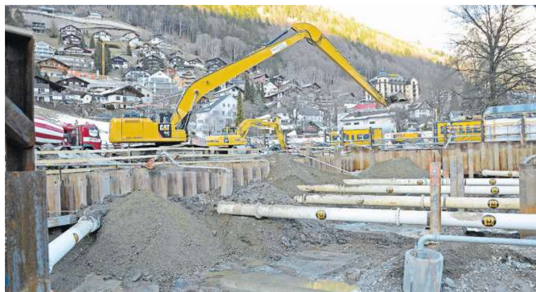
Die Baugrube des geplanten Fünfsternehotels Titlis-Palace in Engelberg.
